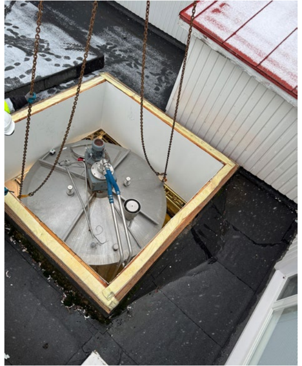
Maitohomogenisaattori vaihdettiin katon kautta
