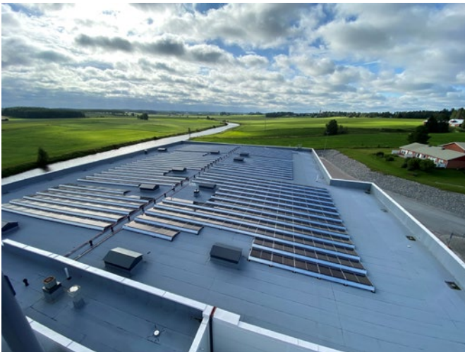
Toholammin meijerirakennuksen katolle asennettiin kesällä aurinkopaneelit.
